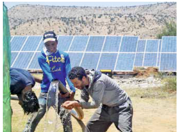
Sistema di pompe solari in Marocco
